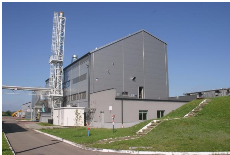
Fig. Elektrociepłownia Lębork, impianto di cogenerazione alimentato a biomassa - miglioramento ecologico della rete di teleriscaldamento https://pfrdlamiast.pl/baza-miejskich-innowacji/lebork-elektrociepownia-na-biomase-ekologiczne-usprawnienie-miejskiej-sieci-cieplowniczej.html
