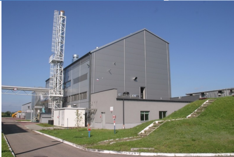
Fig. Elektrociepłownia Lębork, biomass-fuelled CHP plant - ecological improvement of the district heating network source https://pfrdlmiast.pl/baza-miejskich-innowacji/lebork-elektrociepownia-na-biomase-ekologiczne-usprawnienie-miejskiej-sieci-cieplowniczej.html
