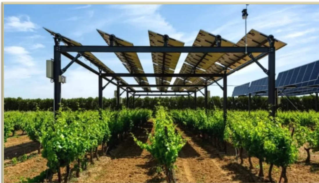
Imagen 1: Vista detallada de una instalación fotovoltaica integrada Fuente: Proporcionada por la compañía
