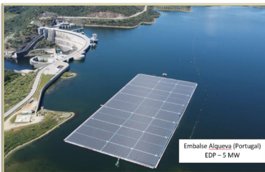
Image 3: Ejemplo de otra instalación fotovoltaica flotante en Portugal Fuente: Aportada por la empresa
