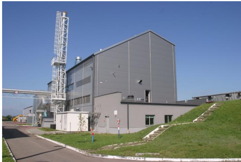
Fig. Elektrociepłownia Lębork, planta de cogeneración alimentada por biomasa - mejora ecológica de la fuente de la red de calefacción urbana https://pfrdlamiast.pl/baza-miejskich-innowacji/lebork-elektrociepownia-na-biomase-ekologiczne-usprawnienie-miejskiej-sieci-ciepowniczej.html
