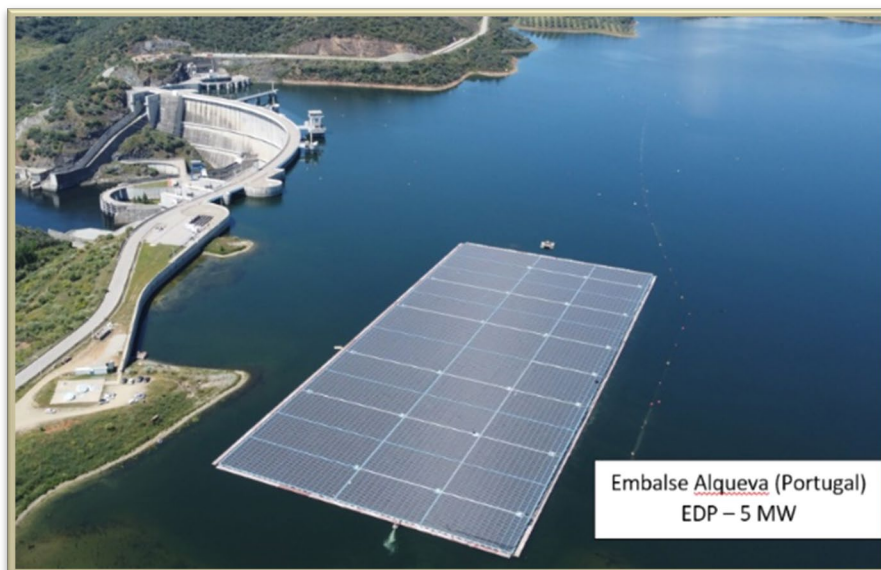
Фигура 3: Друг пример за плаваща фотоволтаична инсталация в Португалия Източник: Предоставена се от фирмата
