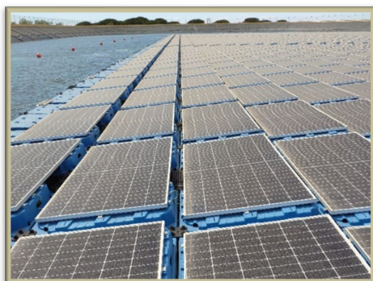
Фигура 2: Детайл от плаваща фотоволтаична инсталация Източник: Предоставена се от фирмата
