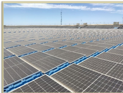
Фигура 2: Детайл от плаваща фотоволтаична инсталация Източник: Предоставена се от фирмата
