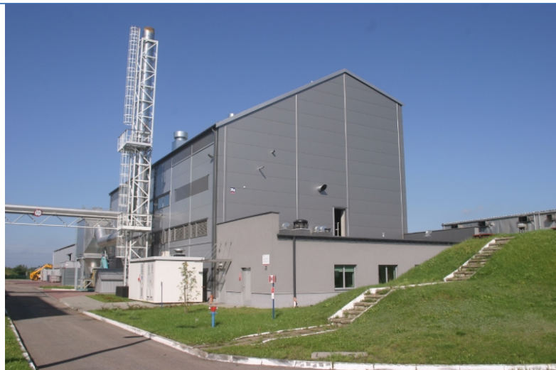
Фиг. Elektrociepłownia Lębork, ТЕЦ на биомаса - екологично подобряване на топлофикационната мрежа
